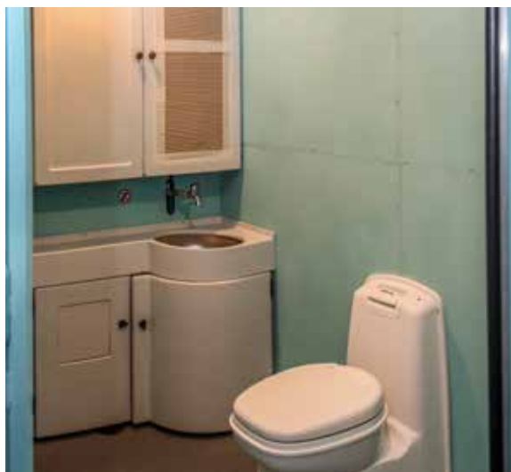
Рис. 2. Санитарный модуль в бустерной секции 1-го типа
