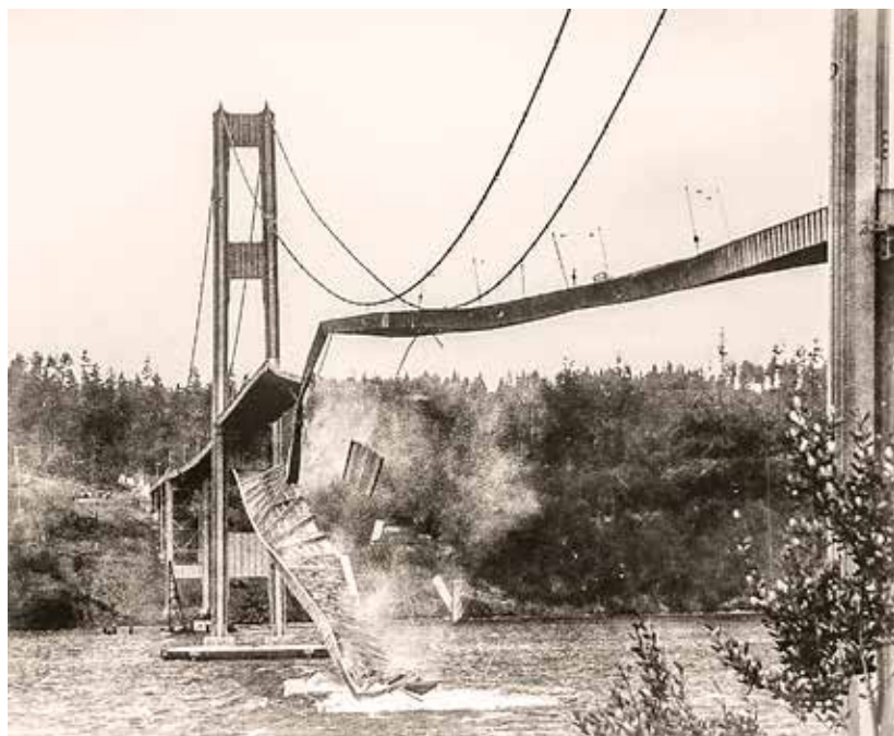
Рис. 1. Разрушение тахомского моста под действием изгибно-крутильного флаттера
