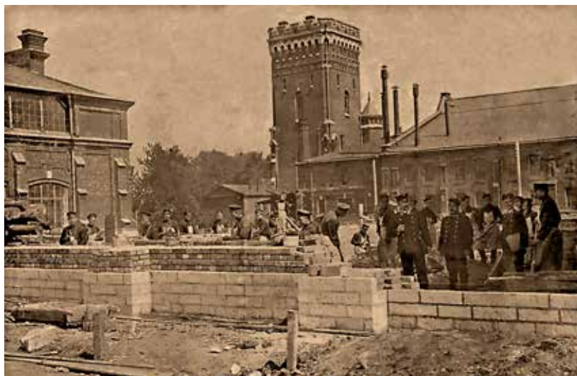
Рис. 5. Строительство новых производственных цехов Александровского завода, конец XIX века
