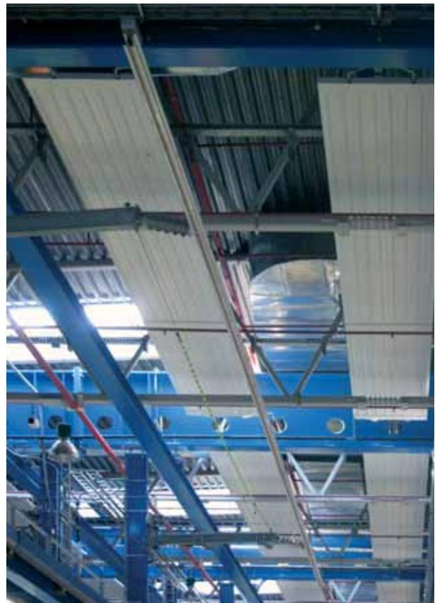
Рис. 5. Отводная шина
