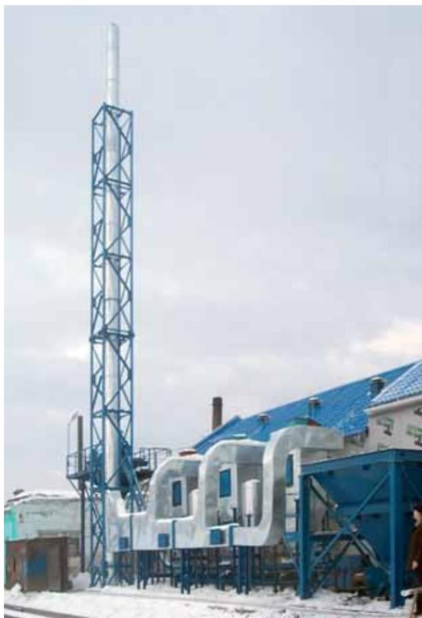
Рис. 9. Первая в Российской Федерации каталитическая теплофикационная водогрейная модульная установка КТУ-3
