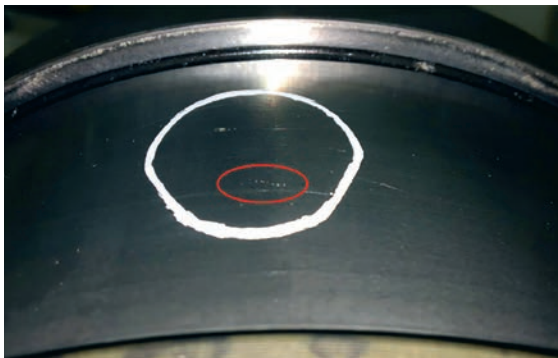
Повреждение внутреннего кольца
